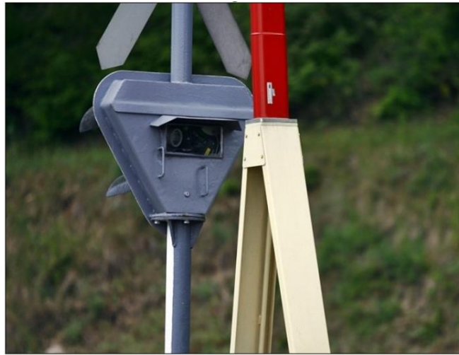
3.kép: Kamerával felszerelt fénysorompó Eplényben a Veszprémi utcai vasúti átjáróban 36
