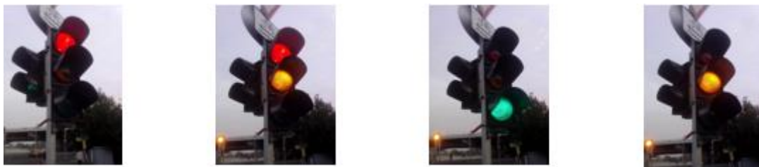
1. számú ábra: Általános járműjelző piros- és zöldfázisai (Forrás: a szerző saját felvételei)
